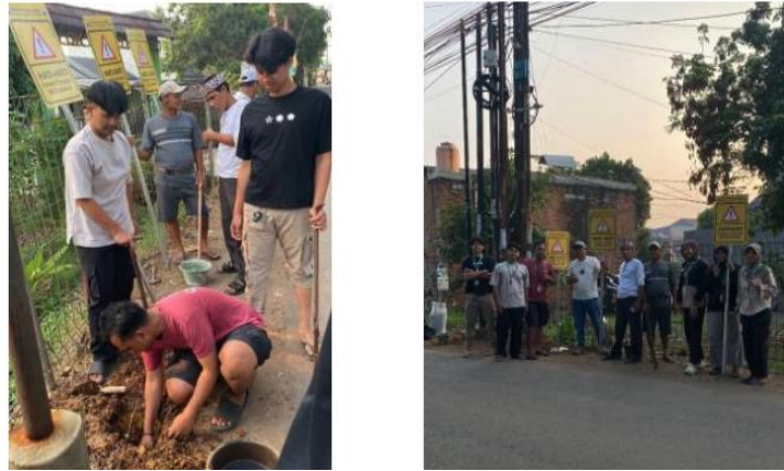
Foto 4. Pemasangan Plang Marka Jalan
